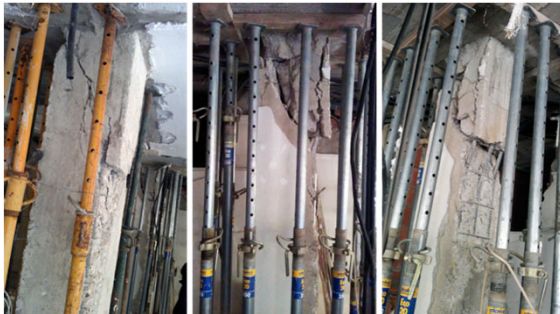
Edificio Pirámide. Lorca. 2011
