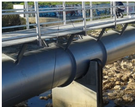
Pasarela-Acueducto Vegas Bajas. 2015
