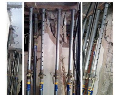
Edificio Pirámide. Lorca. 2011
